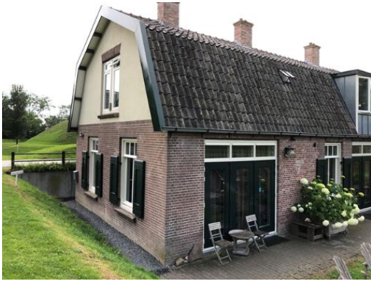
LekArt Air bevindt zich in de linker benedenverdieping van de fortwachterswoning.
